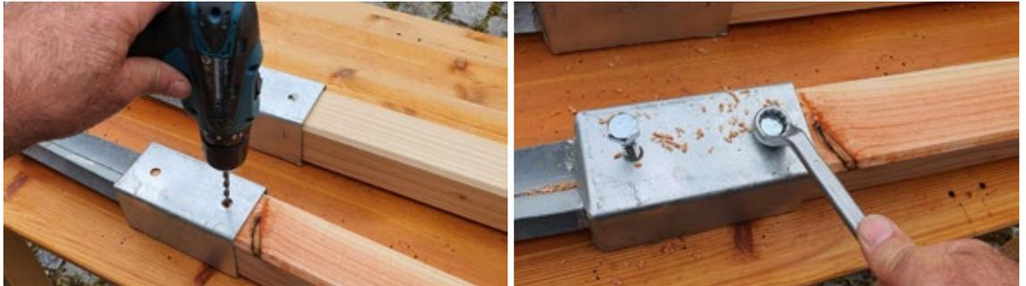
Pfosten in Einschlagbodenhülsen einschieben und mit 6 mm vorbohren.
