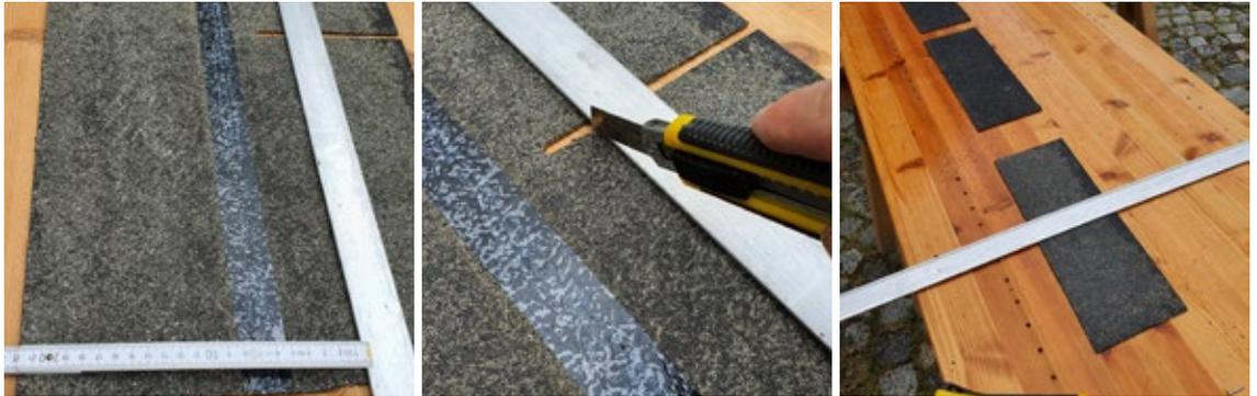
Bitumenschindel mit der Unterseite (ohne Sand) nach oben auf eine Schneidefläche legen (immer von der Unterseite her schneiden). Von der Kante ohne Schlitz aus circa 220 mm abmessen und ein Lineal anlegen. Mit dem Cuttermesser einritzen und brechen. Ein Stück der angeschnittenen Teile nochmals mittig teilen.
