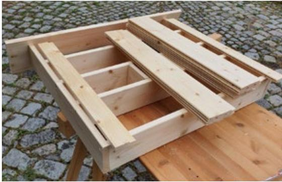
Die Rückwandbretter auflegen, Nut und Feder müssen immer in die gleiche Richtung zeigen.
