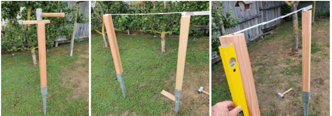
Pfosten mit Hilfe eines Holzstücks als Beilage in den Boden senkrecht eintreiben, je nach Bodenverhältnissen muss vorgegraben werden. Den zweiten Pfosten im Abstand der Insektenhotelbreite (circa 77 cm) einschlagen. Mit einer Wasserwaage überprüfen, ob die Pfosten senkrecht sind.
