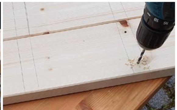
Die beiden Seitenwände im Bereich der Böden mit jeweils 2 Löchern vorbohren (mit 4 mm Bohrer).
