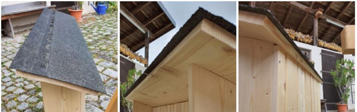
Bitumenschindel auflegen und Überstände vermitteln. Die Bitumenschindel dafür so auflegen, dass sich die Schlitz am Hochpunkt des Dachs befinden und der Überstand an allen Seiten gleichmäßig ist.
