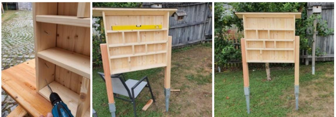
Im Insektenhotel-Korpus je 2 Schrauben pro Seite zur Befestigung an den Pfosten vorschrauben. Ein Stuhl hilft bei der Montage, zuerst eine Seite festschrauben, dann mit Wasserwaage kontrollieren und zweiten Posten anschrauben. Das Insektenhotel ist anschließend bereit zur Befüllung.
