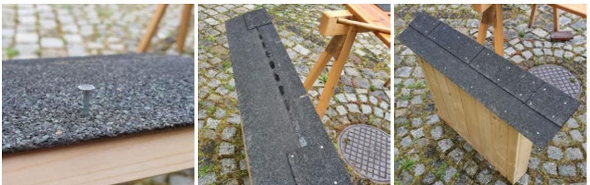
Bitumenschindel ausrichten und mit 2 Dachpappennägeln fixieren.
