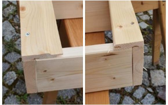
Linkes Rückwandbrett mit 3 Schrauben anschrauben.
