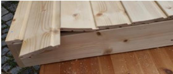
Nun die restlichen Rückwandbretter einlegen. Die Luft zwischen der Nut und Feder-Verbindung gleichmäßig verteilen.
